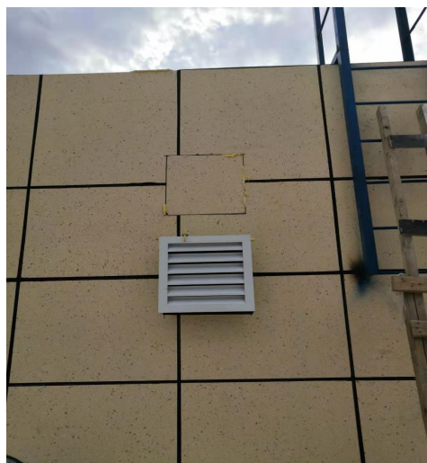
实验室排风井
